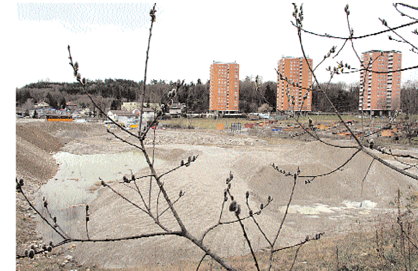
In die ehemalige Kiesgrube im Weissensteinquartier wollen Bern und Köniz eine Mehrfachsporthalle bauen.
